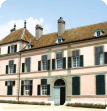
Vue sur le château de Coppet, façade sud photo : Bernd Brägelmann - Wikicommons
